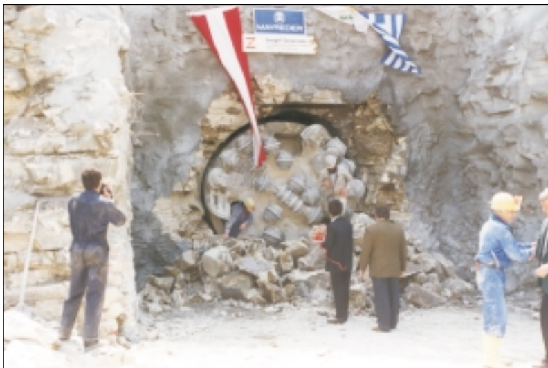
Dhiarizos diversion tunnel
